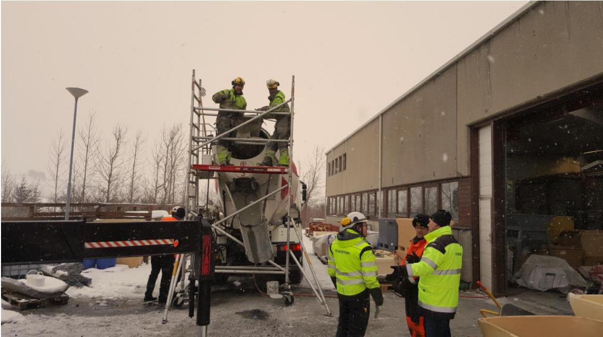
Mynd 18: Fyrirkomulag vinnupalls aftan við steypubíl.
