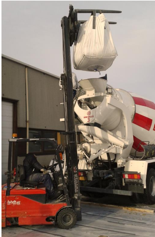
Mynd 16: Blöndun í steypubíl (til vinstri) og losun 6 í ker (til hægri).
