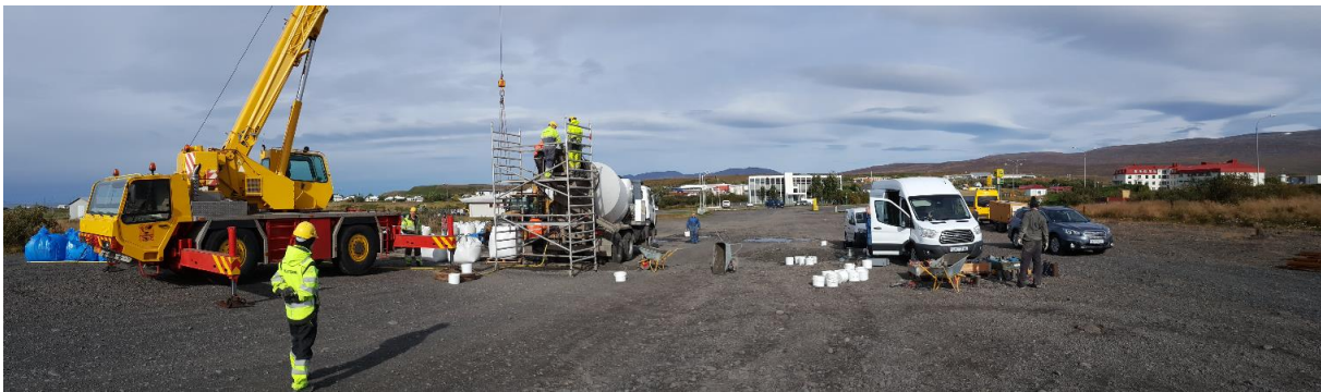
Mynd 21: Blöndun steypu í steypubíl á Blönduósi (14. september 2016).
